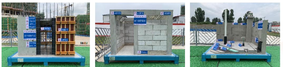
项目部实施策划先行，推行样板引路，在施工现场设置了主体工程、砌体工程、安装工程、装饰工程的样板区及样板层，展示质量控制要点，规范工序过程和验收标准，通过工序样板引路和实施，为工程质量提供重要保障。
